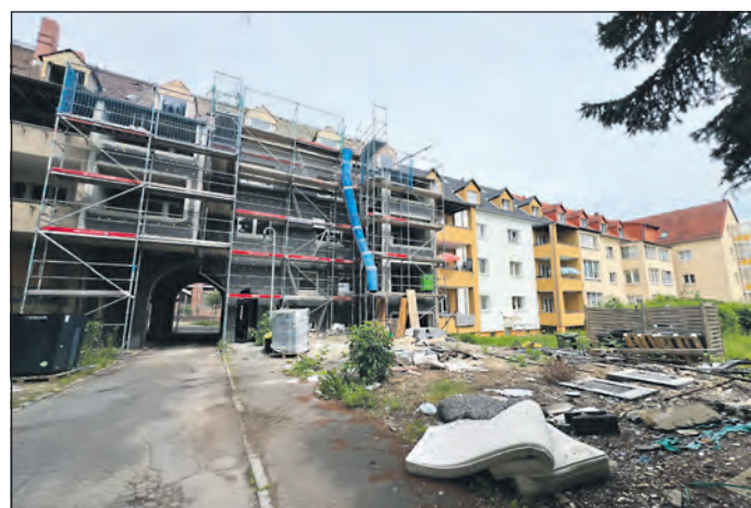
Blick von der Amendestraße auf die Baustelle und die links angrenzenden Gärten der Mehrfamilienhäuser der Franz-Mehring-Straße.
