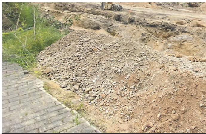
Im Bildvordergrund erkennt man die direkte Abrisskante vom Grundstück der Käthe-Kollwitz-Straße 7 zum Bauplatz.
