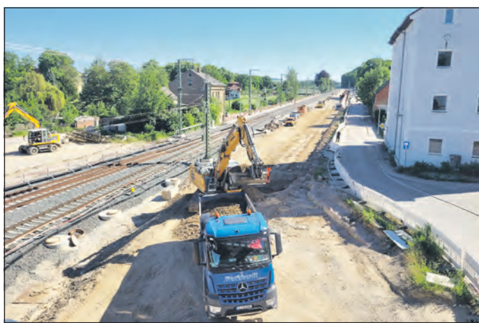
Ein Abschnitt der Baustelle des Bahnknotens in Göbnitz. Foto: GH
