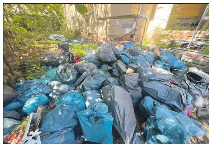
Die Müllansammlung auf der rechten Seite der Baustelle umfasst nicht mehr nur Bauabfälle, sondern auch Restmüll- und Altkleidersäcke.
