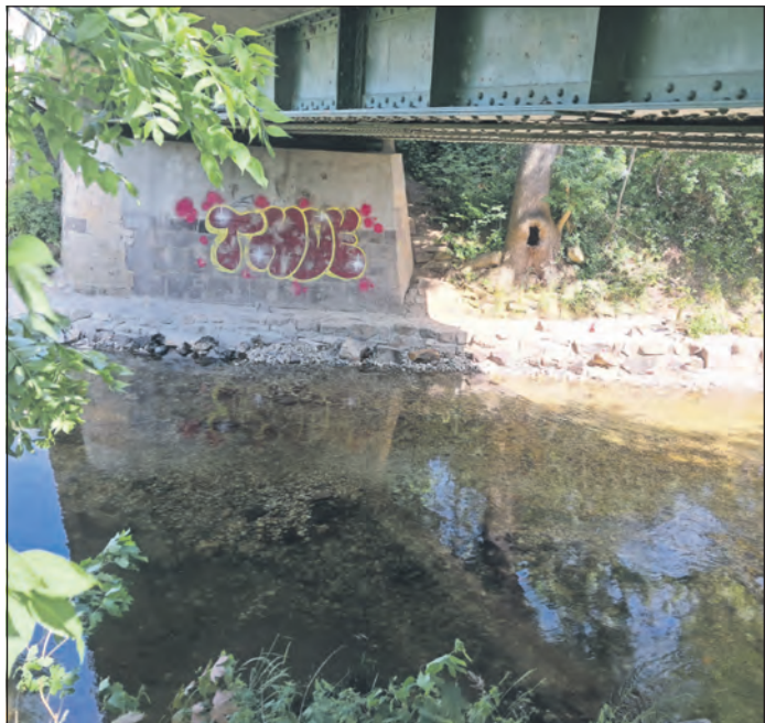
Die fertiggestellte Otterberme an der Pleißebrücke in Zschechwitz. Foto: Landratsamt Altenburger Land
